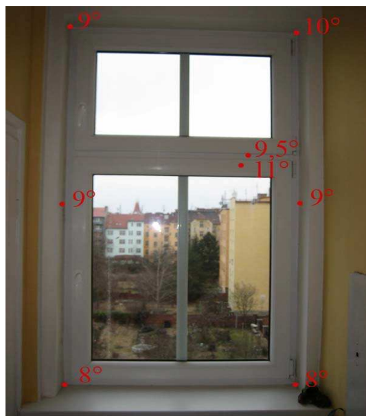
Okno na chodbě
