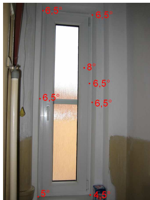
Okno na WC
